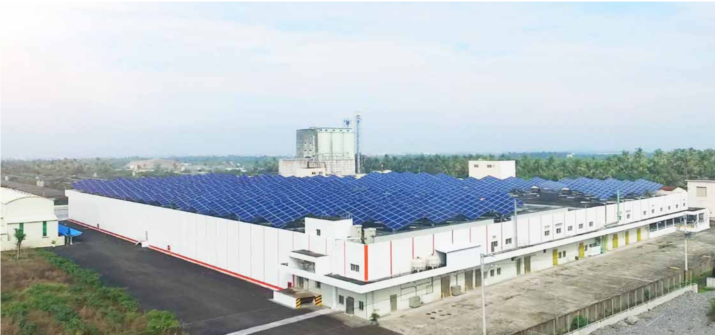
Taiwan Pingtung Power Plant 台灣屏東電站
