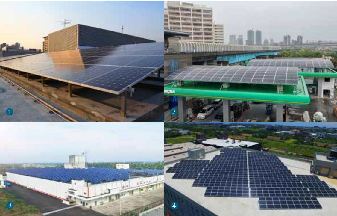
① Taichung City Government ② Roof Top(Arc-shape) ③ World's Largest Dual-Axis Tracker Roof Top ④ Roof Top ① 台中市政府 ② 林口捷運加油站（弧形）③ 全球最大雙軸追日屏東案場 ④ 桃園案場
